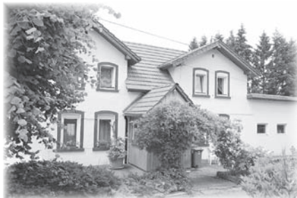
Główny budynek Centrum
